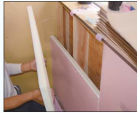
アキレスHCパネルによる断熱リフォーム施工例
