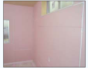
アキレスHCパネルによる断熱リフォーム施工例
