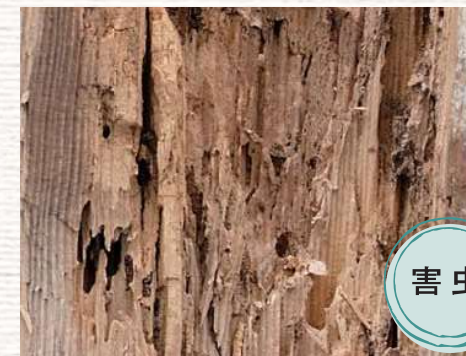
木材害虫の被害を受けた柱。幼虫が内部を食い荒らすので、美観だけでなく強度も著しく低下してしまいます。
