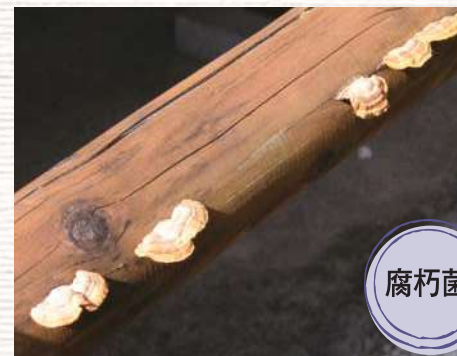
腐朽菌の被害にあった木材。日陰で湿度の高い場所に放置されるとこうした被害が起こりやすくなります。
