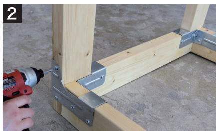
1 で組んだ RTC2Z をねじで固定する。
