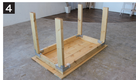
3 で並べた木材の上に 2 で組立てた木枠を中心位置に合わせて乗せる。
