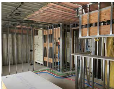
通電前の屋内作業に
