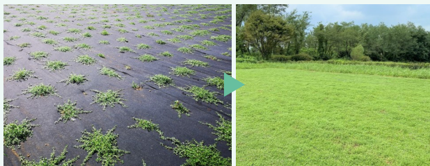
【クラピアマルチシートでの施工例】
