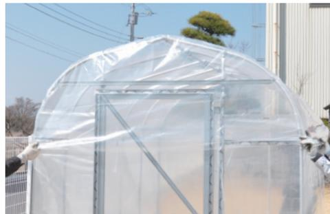
ドア横のタテパイプに取り付けたビニペット EX に屋根用フィルムを止めてからドアと重なっている部分の屋根用フィルムを切り取ります。
