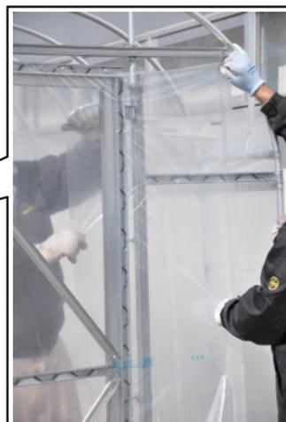
※張り始める際のフィルムの高さにご注意ください。ドア無し面上側のビニペット EX(1.65m)に届き地面から離れないように調節してください。
